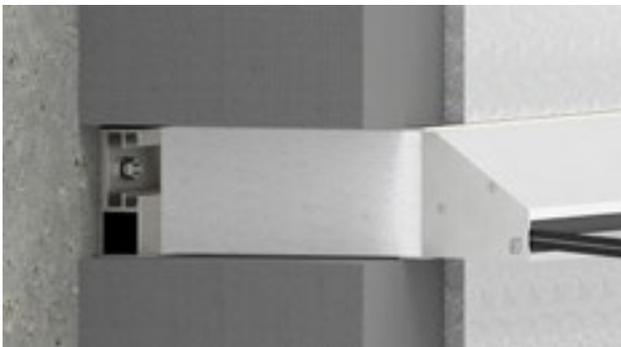
Vordach-Integration in gedämmte Fassaden
